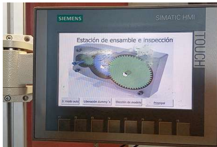
Figura 2 HMI de la estación de ensamble e inspección
